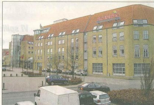
FAC har medvirket på flere af byens store byggerier – blandt andet tagrenovering på Scandic Hotel.
